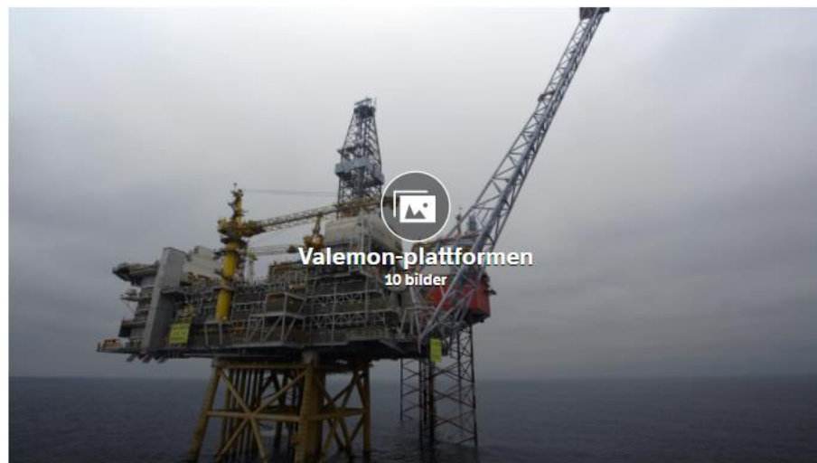
VALEMÓN: Gassplattformen blir den første på norsk sokkel som skal styrast fullstendig frå eit kontrollrom på land.
